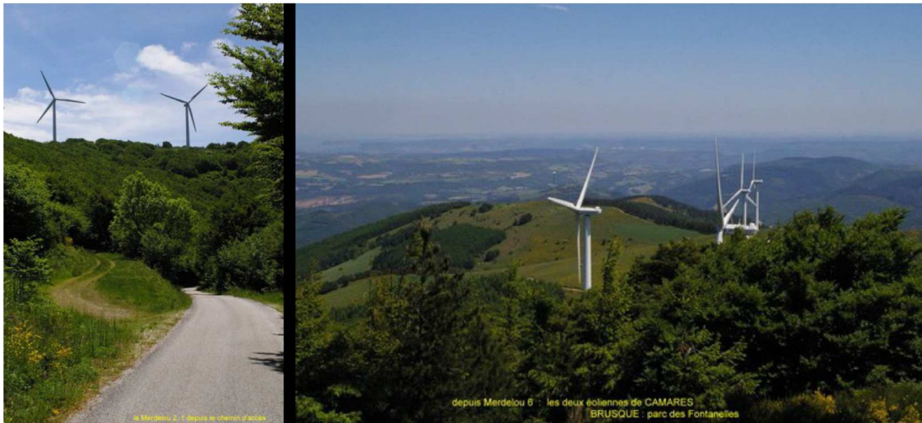
Photo 17 : Vue en contre-plongée et vue en plongée du parc éolien de Merdelou (photo : François Bonnenfant).
